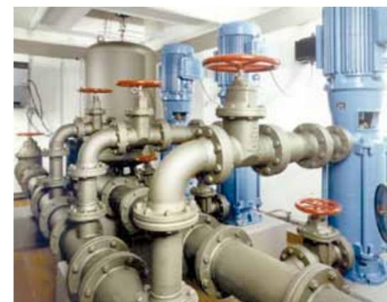
Die vorhandenen Rohrleitungen und Armaturen in der Vorkammer sowie in den Behälterkammern des Hochbehälters Zündhütte zeigten deutliche Verschleißerscheinungen und wurden durch neue Edelstahlrohre sowie moderne Armaturen ersetzt.
