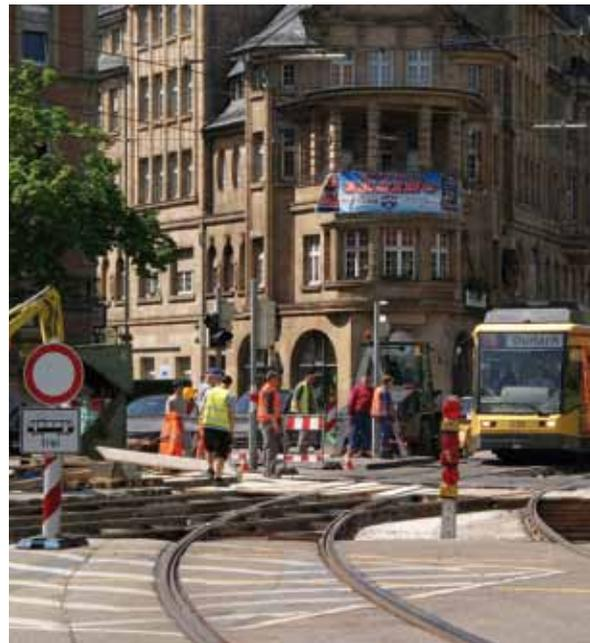
Im Mai 2008 wurde die Haltestelle Schillerstraße in der Weststadt weitere 50 Meter zweigleisig ausgebaut und es wurden die Weichen erneuert. Die Bahnsteigverlängerung auf 80 Meter ermöglicht ein problemloses Halten und Kreuzen von Bahnen in Doppeltraktion.
