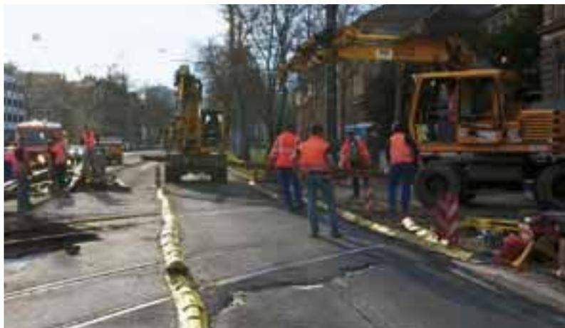
Der überwiegende Teil – etwa 2,8 Kilometer – werden als Rasengleis auf Basis einer so genannten „festen Fahrbahn“ nach dem System Rheda-City-Karlsruhe gebaut, auch das unterstreicht den Alleincharakter des Schienen- und Straßenzugs.
